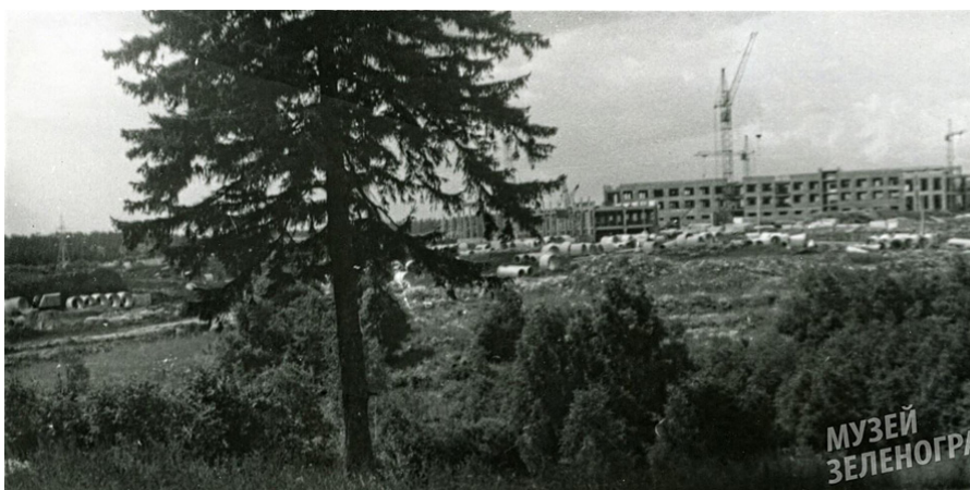
Строительство ЦИЭ, 1989-1990 годы
